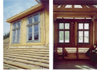
Neu eingebaute Gaubenfenster
